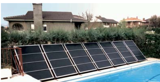
Fig. 3.31. Captadores solares de polipropileno negro. (Cortesía de Europea de Técnicas Ambientales, S.L.).
