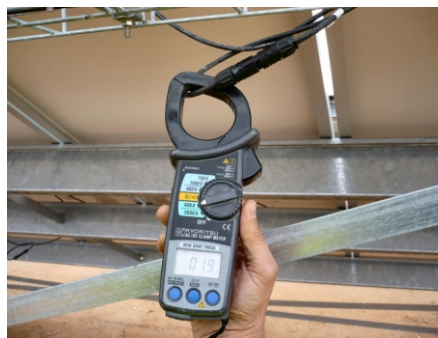
Fig. 9. Medida de la intensidad de la corriente de un módulo fotovoltaico.
