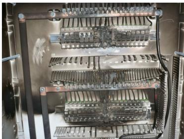
Fig. 1. Cuadro de agrupación de series quemado en la puesta en marcha por un cambio de polaridad.
